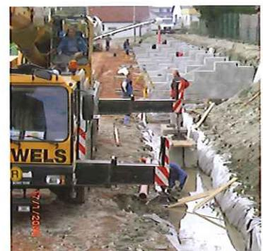
*Die Grabungsarbeiten und Fundamente sind bereits fertig, derzeit werden die Betonfertigteile für die neue Tribüne versetzt. Bis Juni soll die neue Tribüne samt 400 Schallensitzen fertig sein!*
